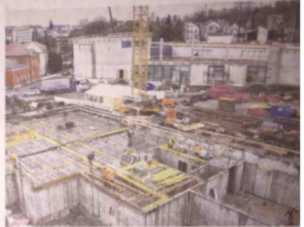
Die Baustellen gestern vom Parkhaus aus gesehen: Vorn Umriss des Hotels hinten die Soletherme, die im Sommer öffnen soll. FOTOS HARALD SALSKE (4)
